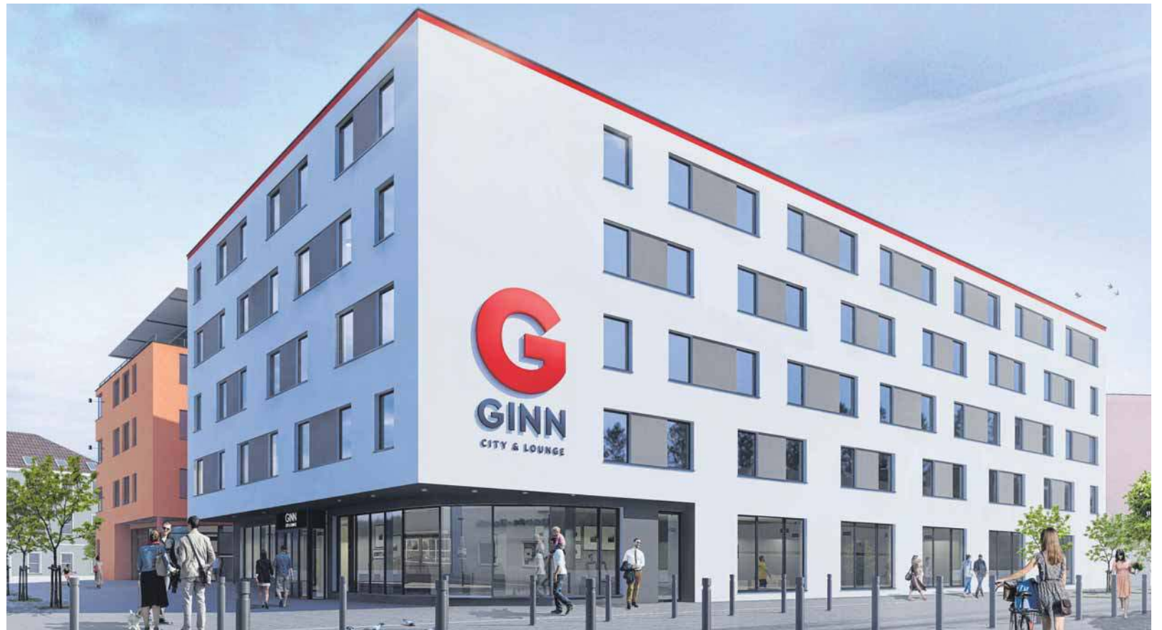
Das Hotel entsteht direkt am Bahnhof. Im Erdgeschoss ist eine Lounge mit Bar geplant.
